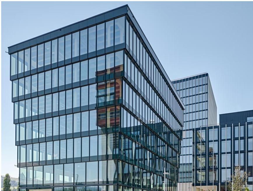
Beim siebengeschossigen Gebäude Suurstoffi 6 handelt es sich um eine Holz-Hybrid-Konstruktion.
